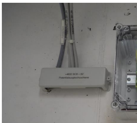
Schienen für den Schutzpotentialausgleich im Gebäude F+G
