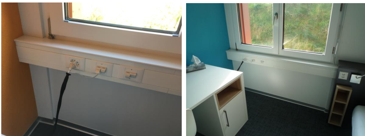
Brüstungskanäle in den Einzel- und Doppelzimmer
