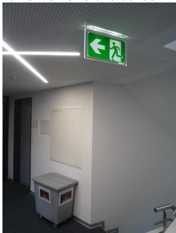
Beispiel Rettungszeichenleuchte und Sicherheitsleuchte mit Einzelakku Im Gebäude E
